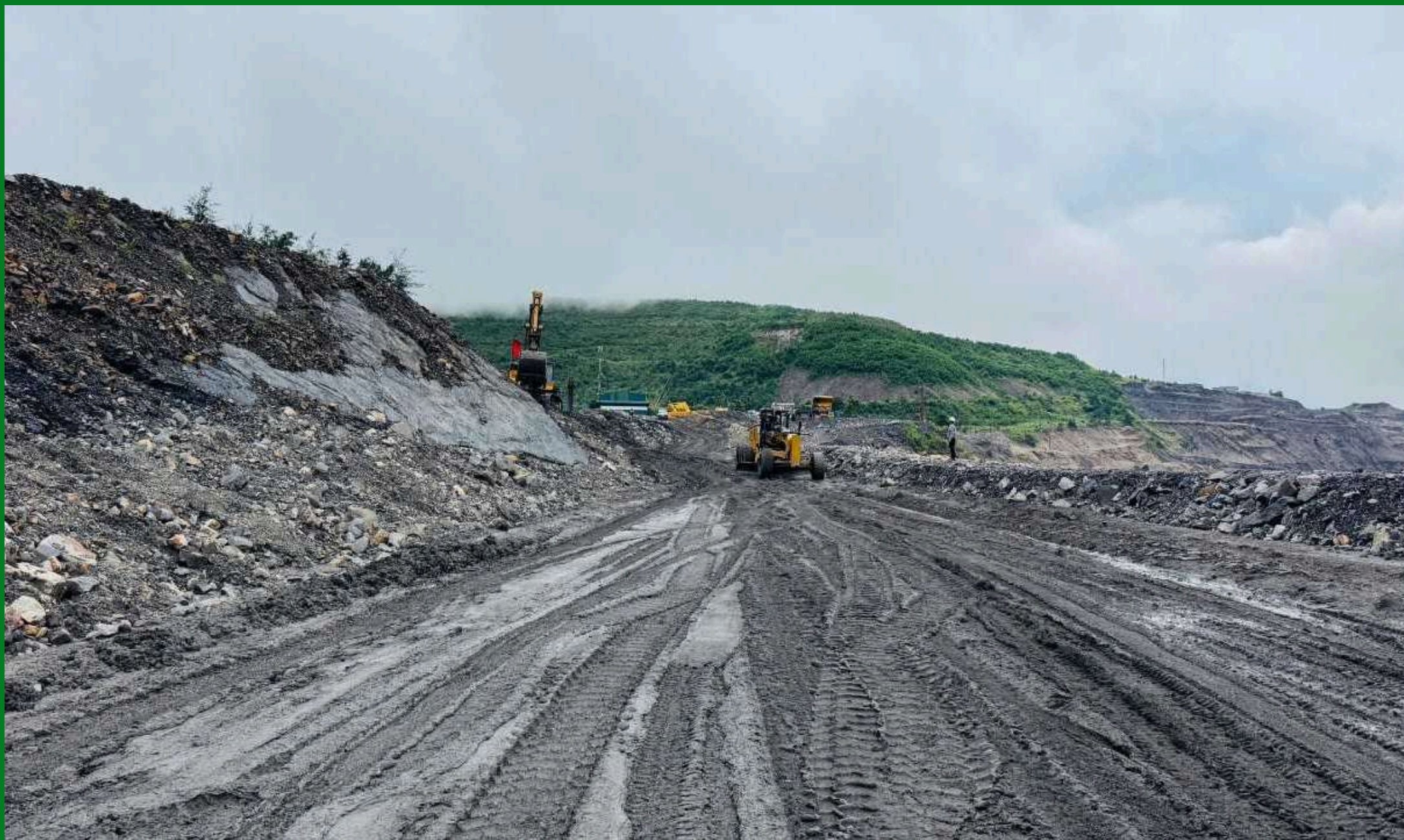
Tổ chức san gạt các tuyến đường vận tải sau mưa bão
