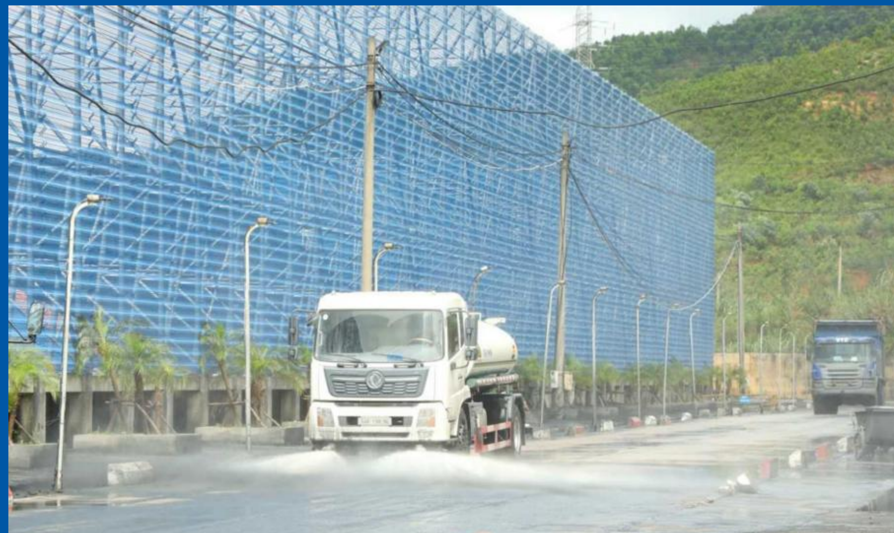
Công ty đầu tư hệ thống lưới chắn bụi cao 14m lắp đặt xung quanh các kho than khu vực cảng, duy trì xe tưới lưới dập bụi
