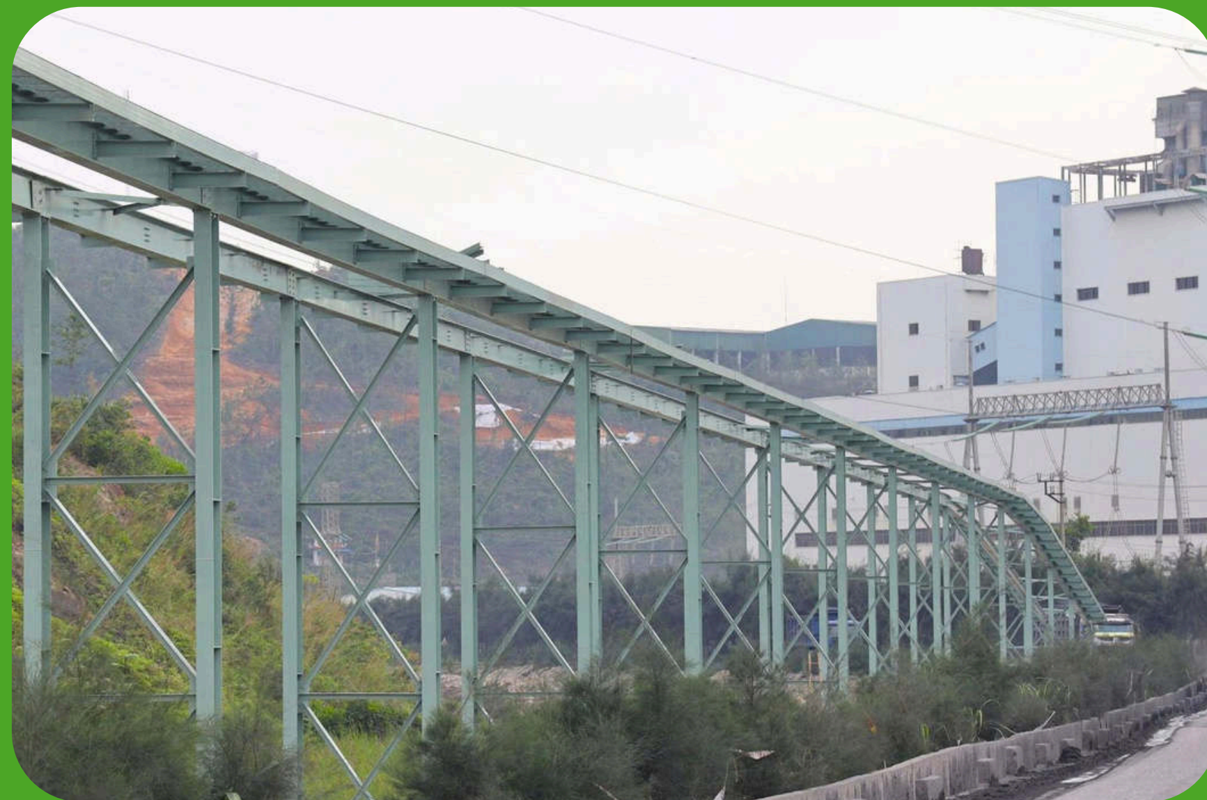
Các tuyến băng tải vận chuyển than có kết nối đồng bộ đang được tập trung thi công, đáp ứng năng lực sản xuất, vận chuyển, chế biến, tiêu thụ than vùng Hòn Gai
