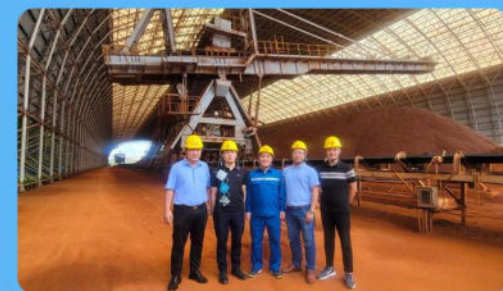
Cán bộ của IMSAT khảo sát hiện trường phục vụ công tác nghiên cứu lựa chọn công nghệ và thiết bị
